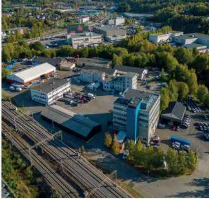
1) Alna Park (Strømsveien 221-223 og Breivollveien 13), 12 900 kvm
